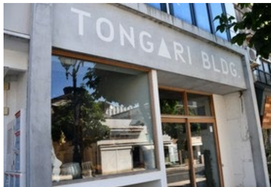
【図 A-2-2】 とんがりビル
