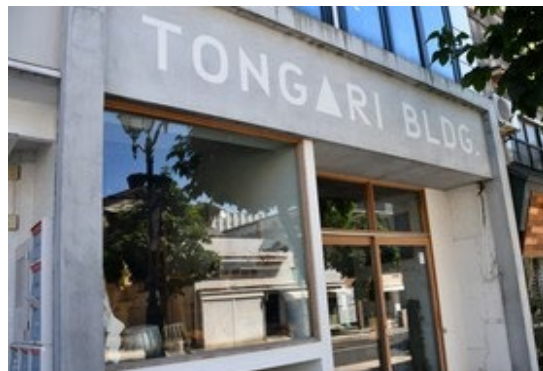
【図 A-2-2】 とんがりビル
